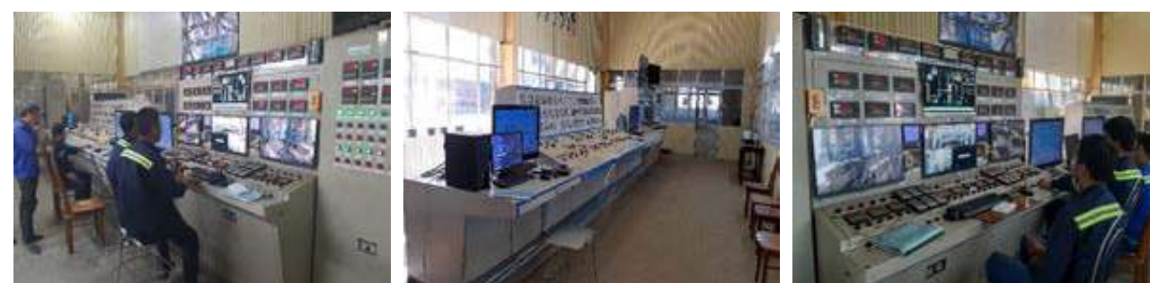
Bàn điều khiển lò hơi, tua bin tại Nhà máy TTC - Attapeu
